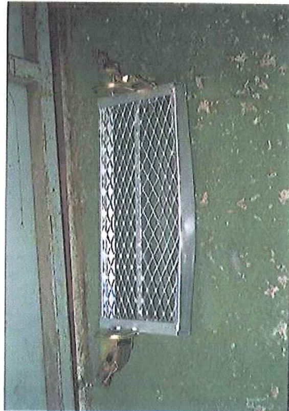
先端部荷重試験後
